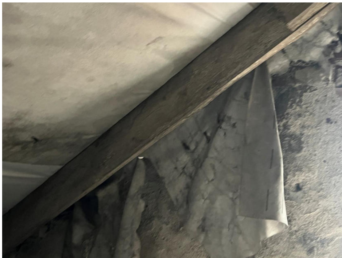
70 pav. Nuplėšta stogo difuzinė plėvelė
