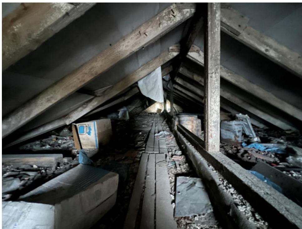
67 pav. Stogo konstrukcijų fotofiksacija
