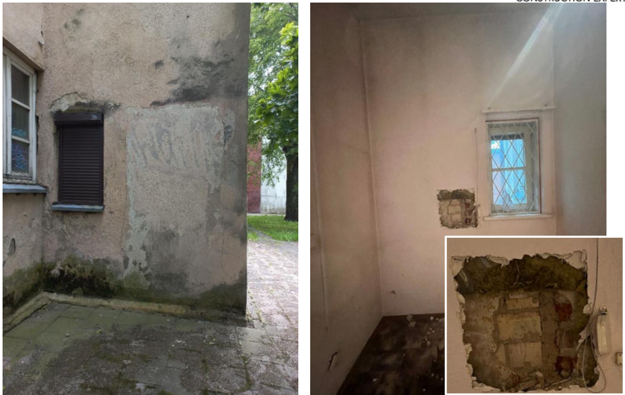
47-48 pav. Užmūrytų durų ir nustatymo mūro medžiagiškumo fotografacija
