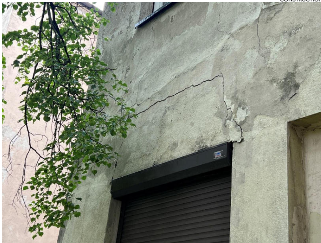
17 pav. Tinko suskeldėjimai virš lango vakarinėje pastato dalyje
