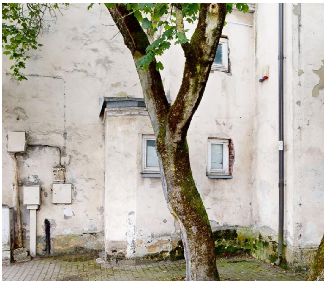
18 pav. Pastato fasado fragmentas iš šiaurinės pusės
