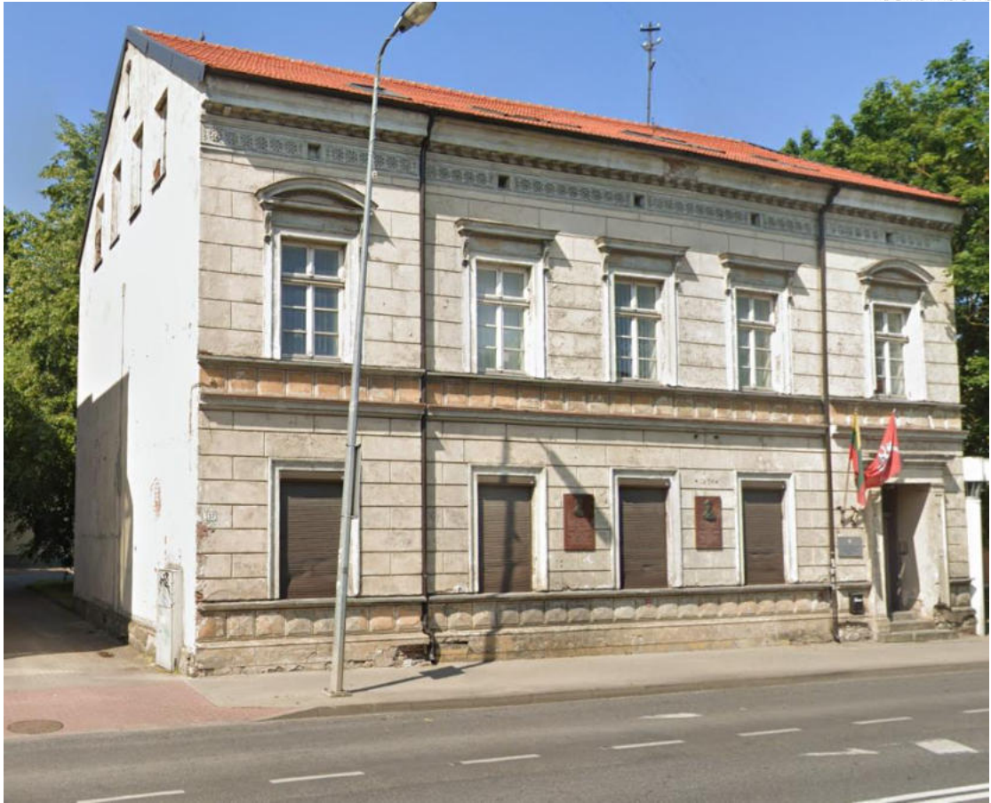
6 pav. Pastato rytinio fasado fotofiksacija
