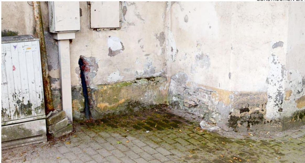
14 pav. Pastato cokolinė dalis šiauriniame fasade
