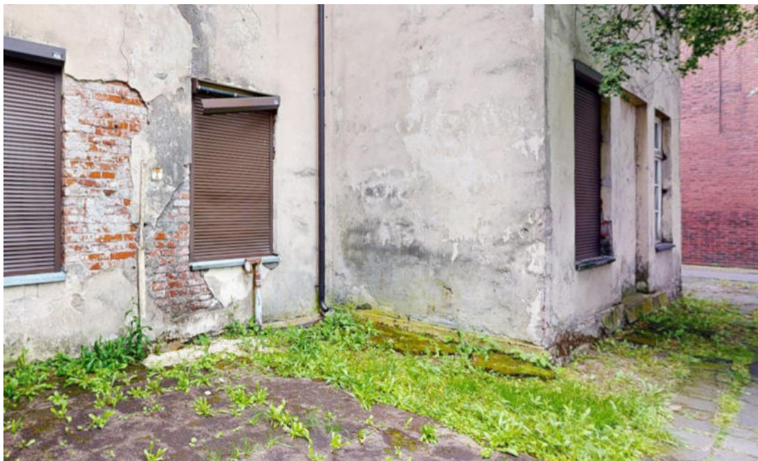
8 pav. Pastato cokolinės dalies ir fasadinės sienos vakarinėje pastato dalyje fragmentas
