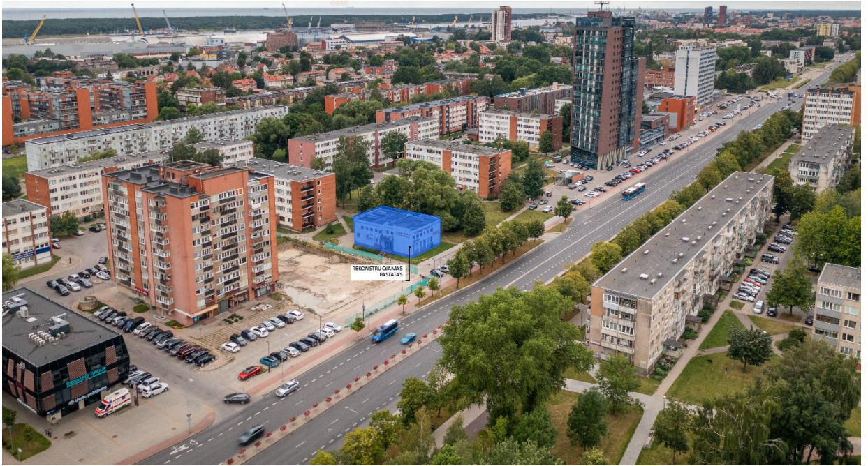
1 pav. Rekonstruojamo pastato vieta
