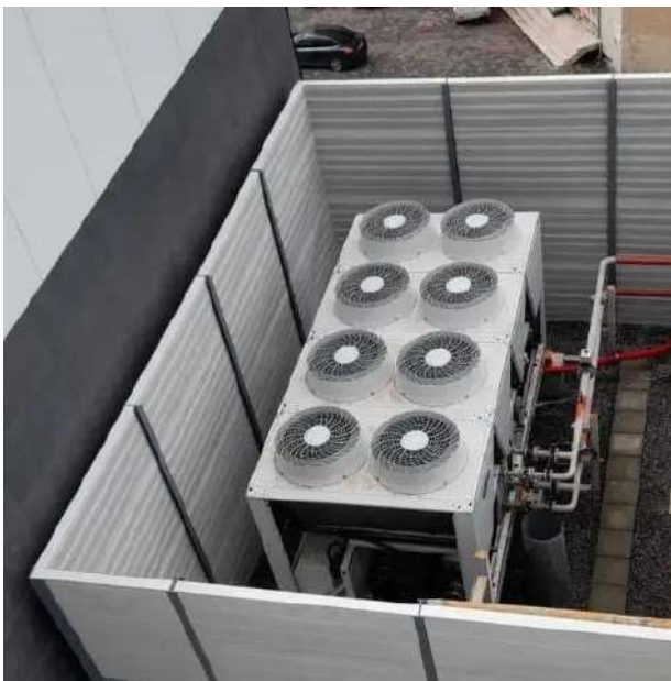
13.1 pav. Pavyzdinė akustinė sienutė prie šalčio mašinos
