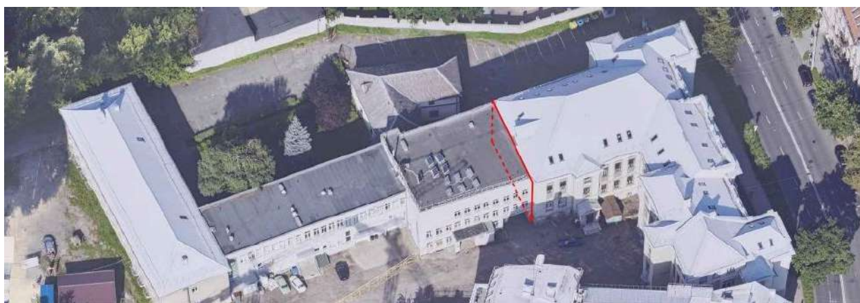
Pav. Nr. 4. Užstatyto buvusio fasado vieta
