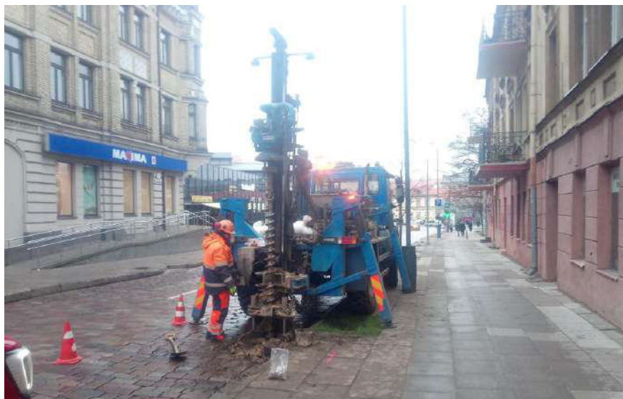
1 pav. Lauko darbai
