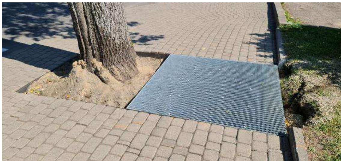
Pav. 7. Laidžios dangos ant polių pavyzdys.
