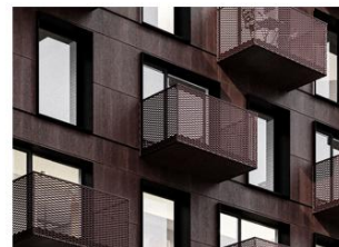
Dažyta trisluoksnių panelių fasado apdaila
