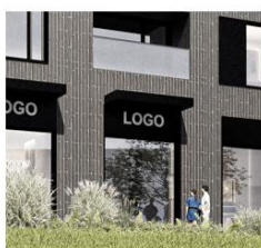
Faktūrinė trisluoksnių panelių fasado apdaila
