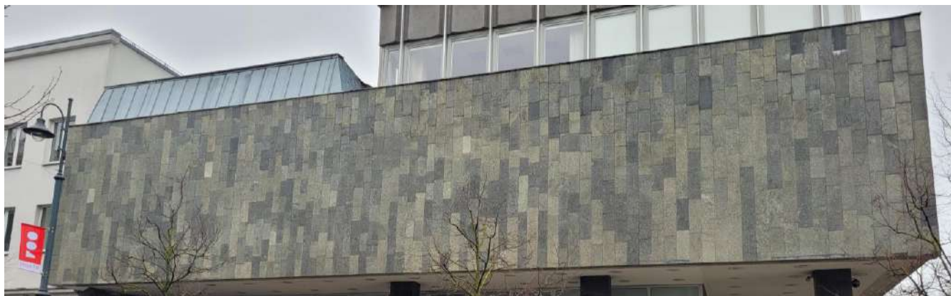
Remontuojamo antro aukšto granino akmens fasado fragmentas.
