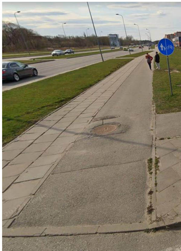
3 pav. Esama takai šalia Šiaurės pr. 13
