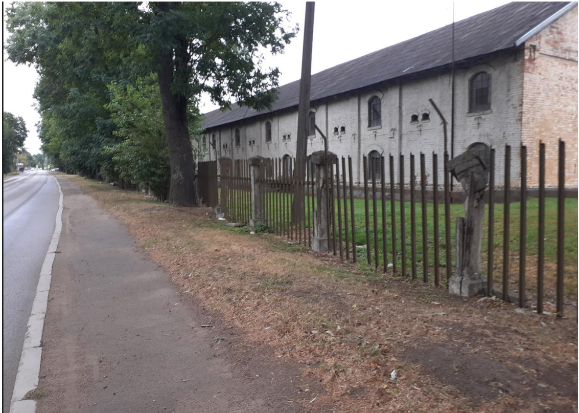
7 pav. esamos situacijos fotografacija – ties Aleksoto malūno statinių kompleksu
