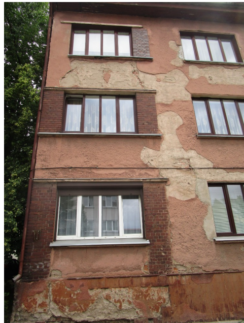
12 pav.. Cokolio ir tarpangių apdaila klinkeriu. Horizontalūs langų karnizai
