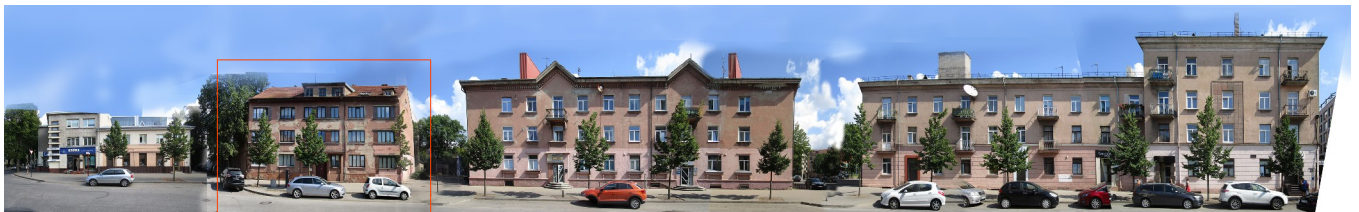
2 pav. S. Šimkaus gatvės išklotinė tarp S. Daukanto g. ir M. Mažvydo al.
