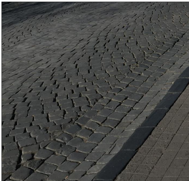
Važiuojamosios dalies latako ir šaligatvio atskyrimo juodo bazalto trinkelų eile pavyzdys Pilies gatvėje
