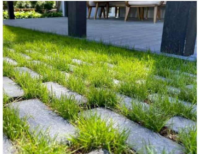
21-22 pav. Mišrios pėsčiųjų tako dangos analogas: dalis tako įrengiama naudojant betonines trinkeles, dalis tako pakraščių įrengiami naudojant drenuojančio tipo ažūrinės trinkeles, tarpus užsėjant žole
