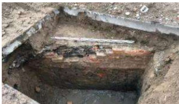
Šurfas Nr. 2. Atidengta iš plytų formuota struktūra datuojama XX a. II p. Plytomis apmūryta šilumos kolektoriaus sienelė.
