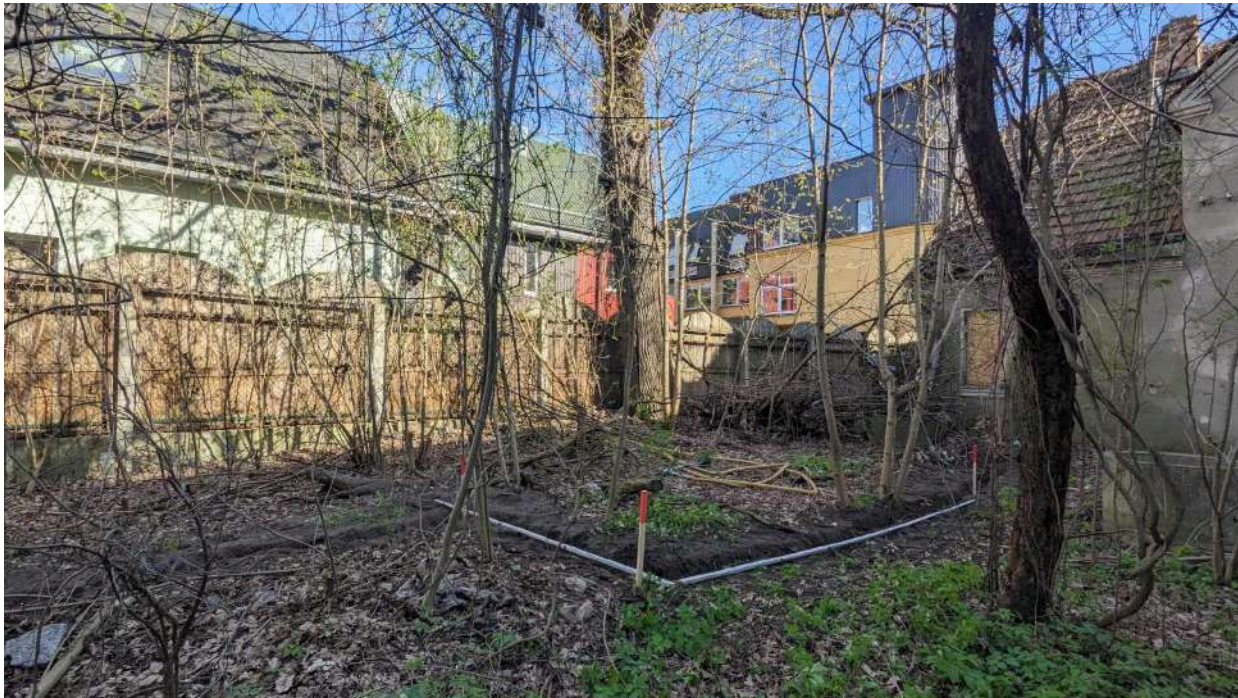
Pav. 4.3.4. Šaknų revizinė tranšėja oro kastuvo pagalba buvo iškasta palei projektuojamų statinių perimetrą.
