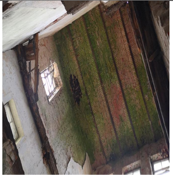
10. Archyvo pastato vidus, dešinė, perdanga iš metalo konstrukcijų su arkinio mūro segmentais
