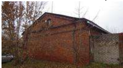
321 Šiaurės vakarų fasadas
